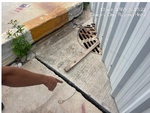
พบการทรุดตัวของพื้นขอบบ่อพักหน้าโครงการ
