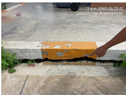
พบการทรุดตัวของพื้นฟุตบาทป้อมตำรวจ
